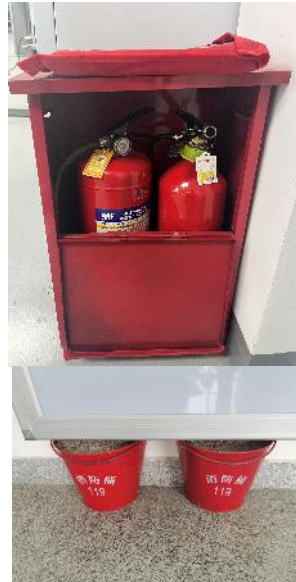
实验室内配备干粉、二氧化碳灭火器、灭火毯
