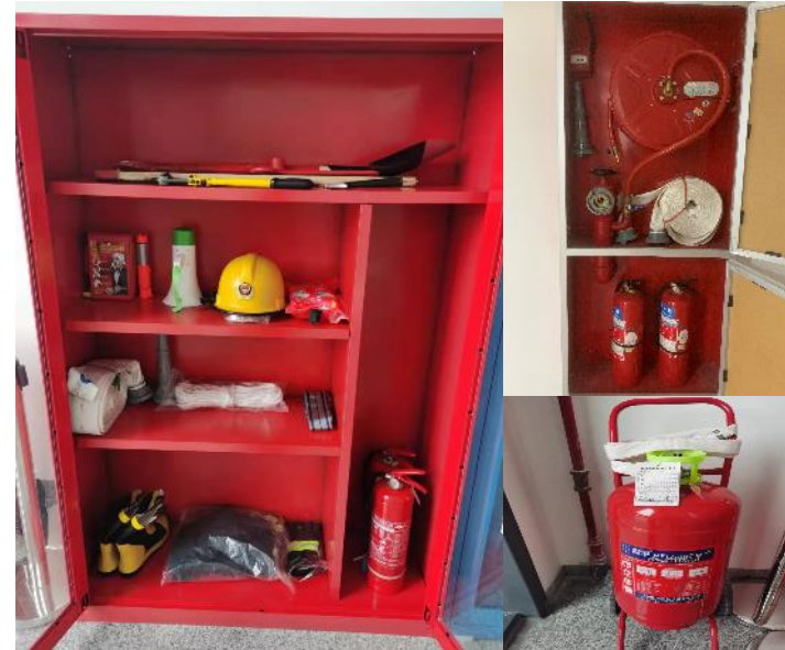
大楼公共区域配备微型消防站、消防栓、手提及手推车式灭火器
